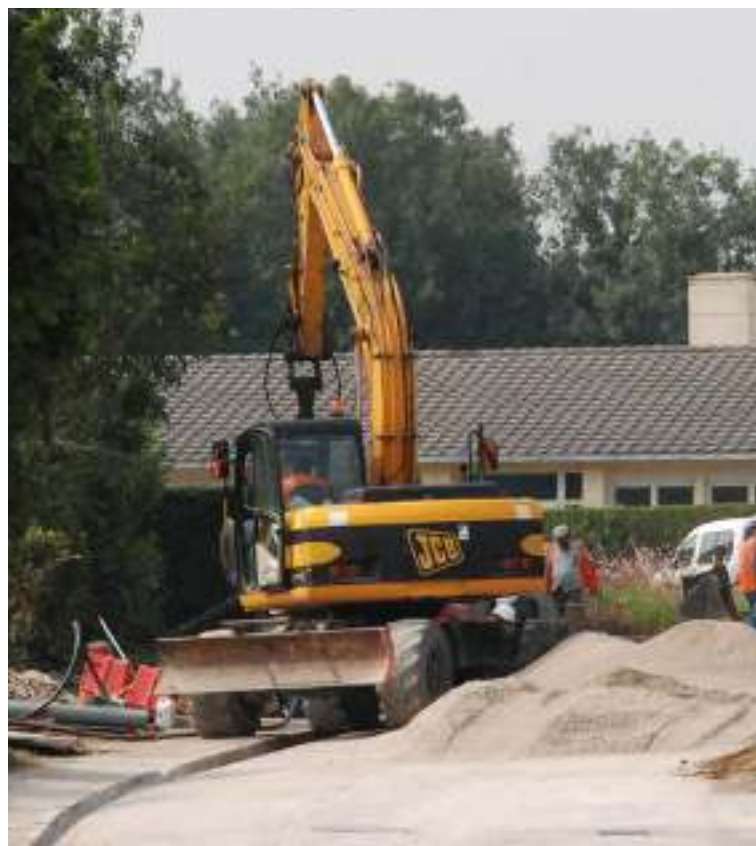
La fin des travaux est prévue pour début octobre aux alentours du groupe scolaire Jean-Ferrat.
